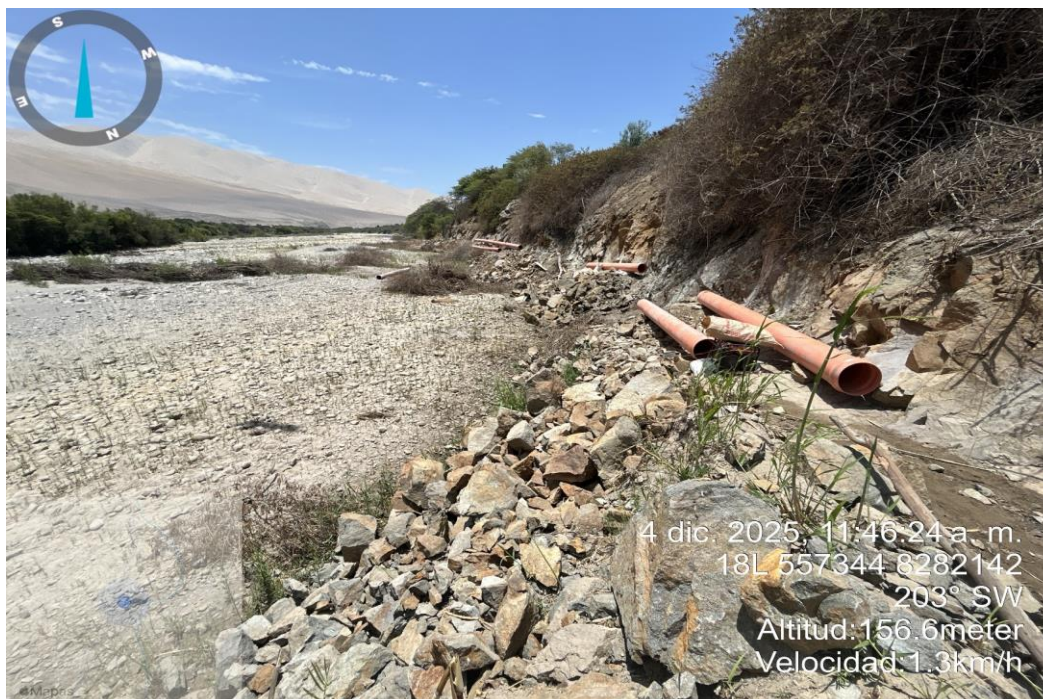
FIGURA N°02: PRODUCTO DE LA ULTIMA AVENIDA EL CANAL DE TIERRA SE EROSIONO Y DESAPARECIO, MARGEN DERECHA, SECTOR MOHICA BAJA, DISTRITO DE JAQUI, PROVINCIA DE CARAVELI, DEPARTAMENTO DE AREQUIPA
